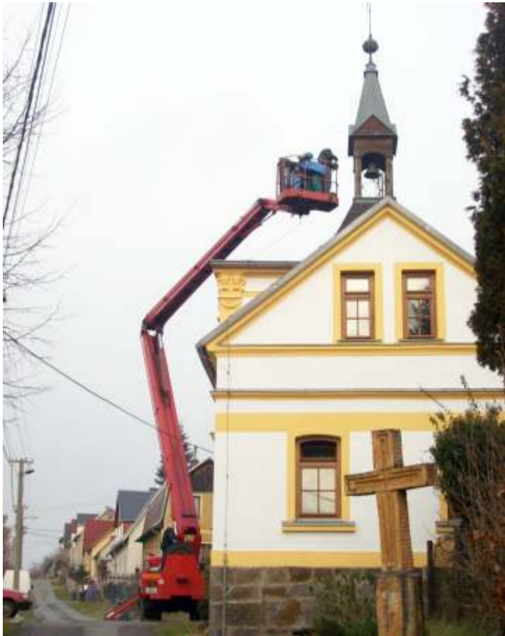
Firma Jiří Štika opravuje dřevěnou zvonici na dolnopoustevneské kapli.
