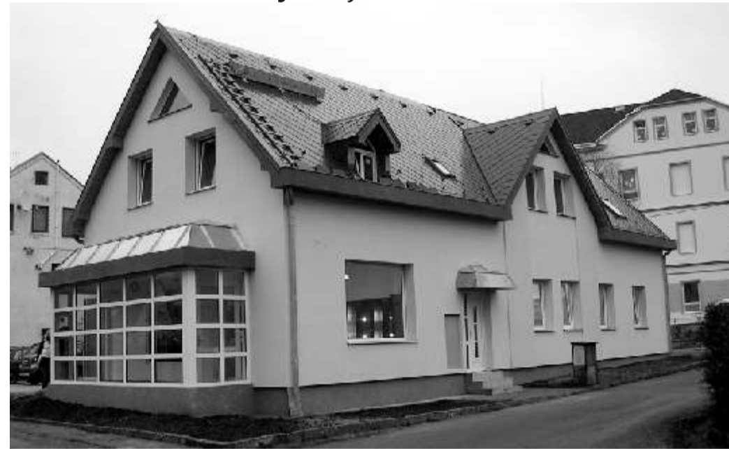
Občané si jistě všimli, že ve druhé polovině roku 2008 proběhla rozsáhlá rekonstrukce domu čp.423 vedle ZDŠ (objekt bývalé pekárny). Jen pro upřesnění uvádíme základní informace: novým majitelem objektu je Ing. Ladislav Brada ze Šluknova. Rekonstrukci prováděla firma Wakos z Rumburka. Stavební úpravy se týka- ly nástavby a přístavby objektu včetně zpevněných ploch okolo na změnu užití „Lékárna a dva přilehlé byty“. Začátkem ledna 2009 byla již provozovna otevřena. Foto i text: Vilém Madunický
