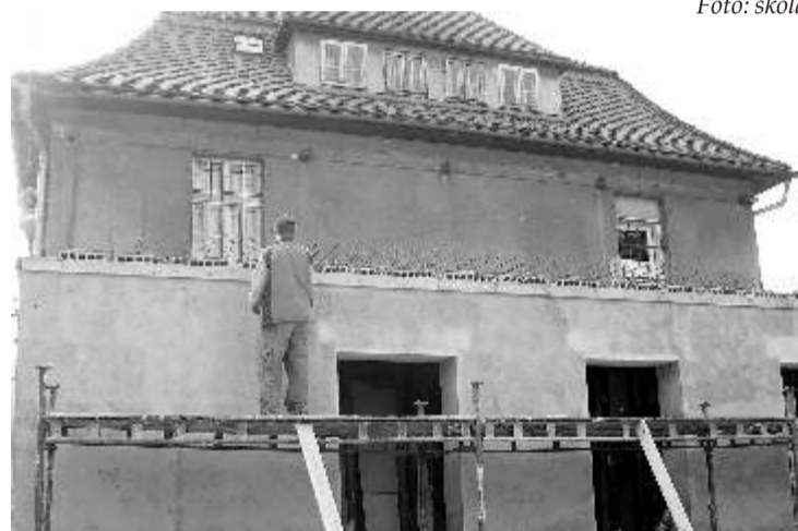
Opravy běží! Oprava havarijního stavu přístavby na MěÚ pokračuje dle harmonogramu prací. Firma KM Nezmar z Dolní Poustevny v průběhu srpna provedla celkovou demolicí původní přístavby a v měsíci září postavila přízemí nové přístavby. Jsou zhotoveny vnější a vnitřní omítky a betonuje se podlaha pro druhou podlaží.
