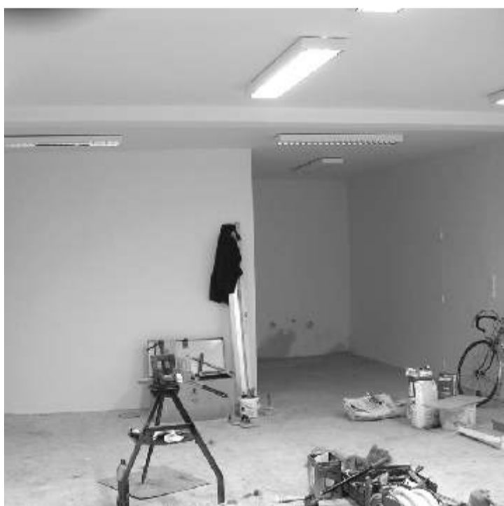
Rekonstrukce v prvním podlaží.
